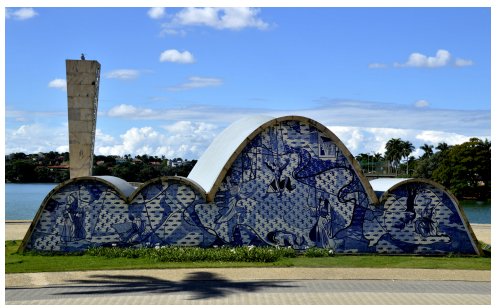
Figura 5: Igreja da São Francisco na Pampulha
